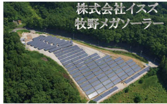
緑区牧野に建設した「牧野メガソーラー」
